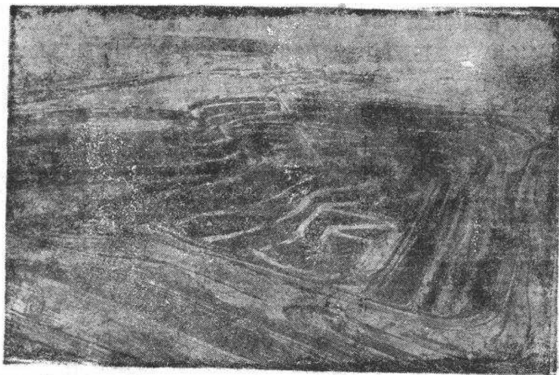
照片 6.1 美国加利福尼亚州 Boron 地方的硼酸盐露天矿及其邻近的加工厂 [矿石由 400 m 的传送机皮带(见中心最明显的地方)运出矿井。(照片承蒙美国硼砂和化学制品公司赠送)]
